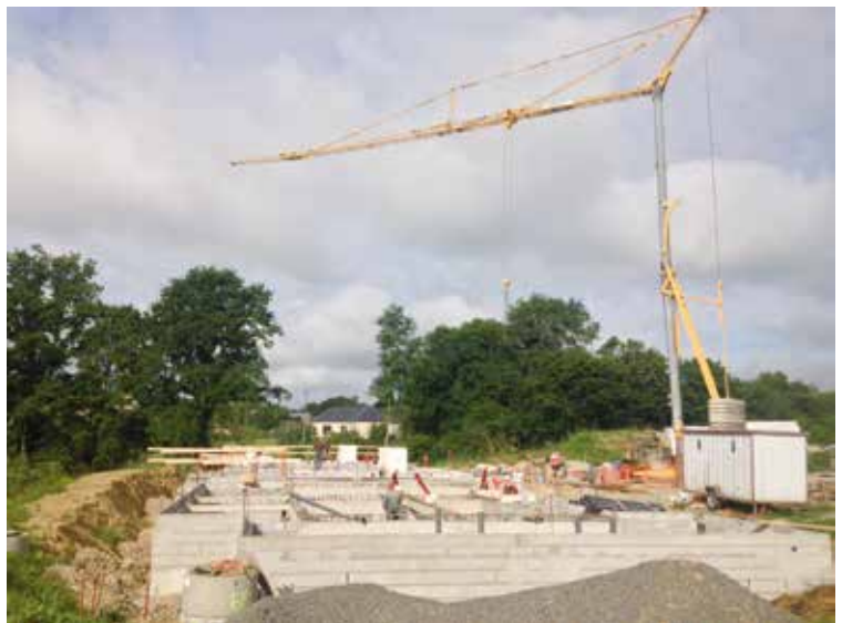
> Beau chantier de Mayenne Habitat, programmé pour une mise en service en début 2020
