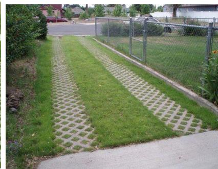
Structure béton alvéolé avec bande de roulement
