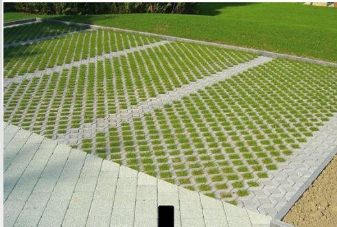
Structure béton alvéolé engazonnée
