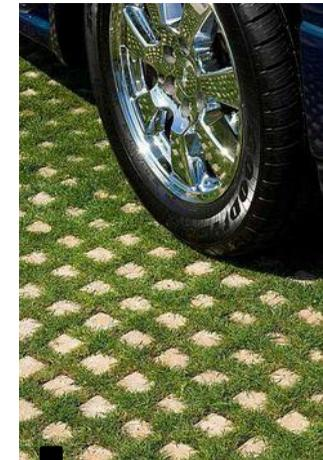
Structure béton engazonnée
