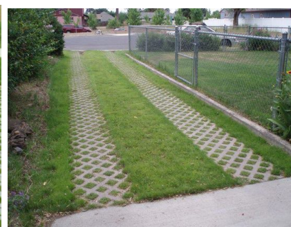
Structure béton alvéolé avec bande de roulement
