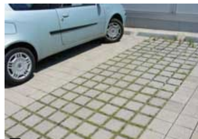
Pavés non jointifs encastrés
