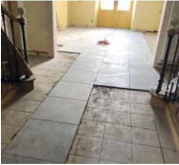
nous avons pu faire le carrelage de tout le rez de chaussée hors salle du conseil. Nous avons eu quelques frayeurs à cause d'un mélange à la livraison qui a nécessité le décollage d'une partie et la réappro en conséquence. Malgré cela le planning n'a pas dérapé
