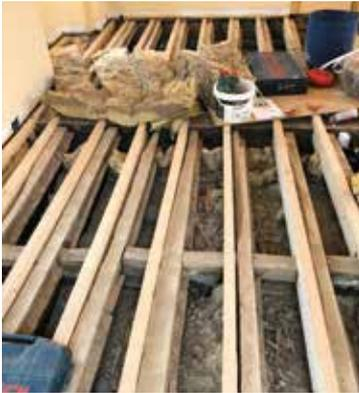
sage du solivage qui avait mal vieilli. Nous en avons profité pour enlever le torchis d'origine et le remplacer par de la laine de roche, et retraiter les anciennes solives. Une fois la préparation du support faite, les
