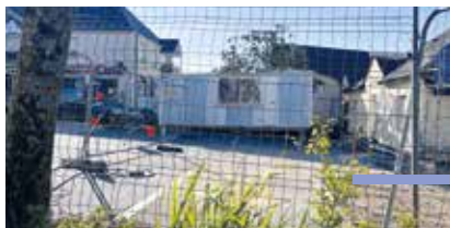
Chantier de la maison médicale lancé Avril
